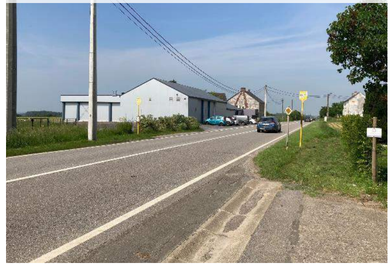
N40 – traversée de Vodecée
