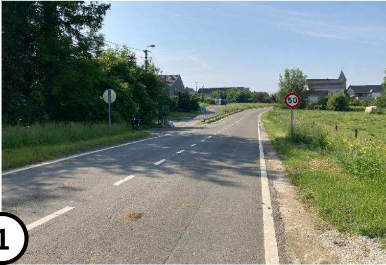
N98 – rue du Vivier : entrée Nord
