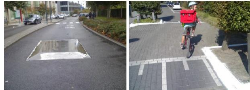
Photo 1 : Exemples de ralentisseurs adaptés aux cyclistes (source : Presto, Modération du trafic et cyclisme)
